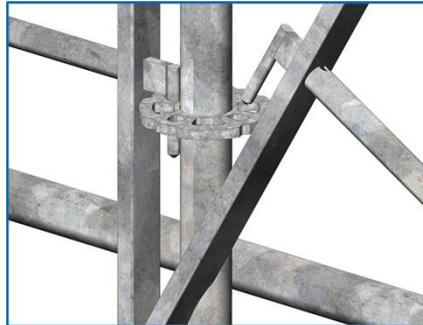
Puis verrouiller les clavettes au moyen d'un marteau ; voir figures 1.6.1 & 1.6.2.
